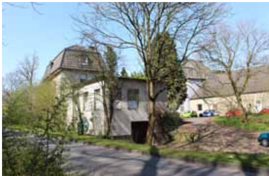
ABB 006 Westwall mit städtischem Gebäude Quelle: SSR
