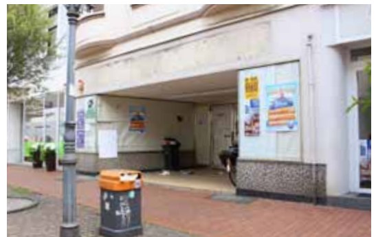
ABB 045 Leerstehendes Ladenlokal Gelderstraße
