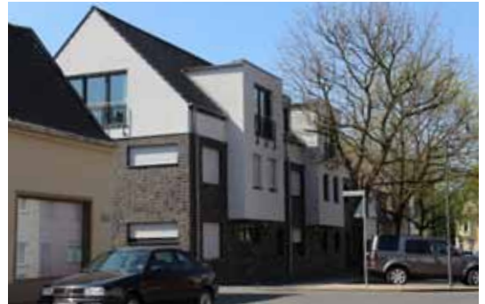
ABB 032 Wohnungsneubau im historischen Ortskern Quelle: SSR
