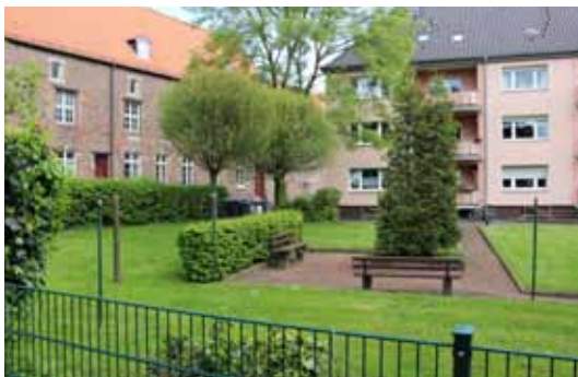
ABB 030 Wohngebäude mit gemeinschaftlichem Hof Quelle: SSR
