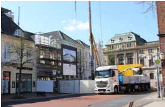
ABB 029 Baustelle des neuen Hotels am Fischmarkt Quelle: SSR
